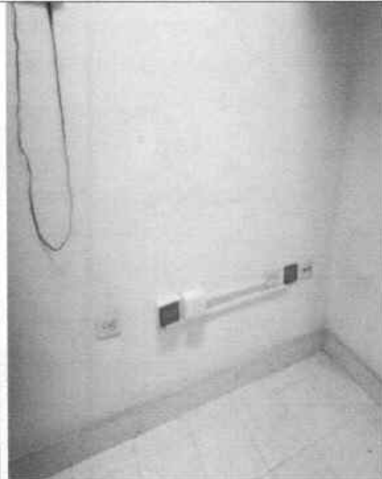
Imagen 18 Salidas de tomas por canaletas Bocono
