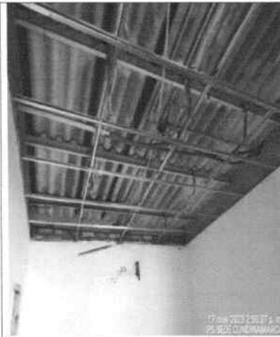
Imagen 9 Acometidas y alimentadores Cundinamarca
