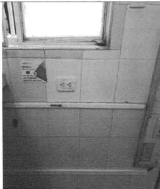
Imagen 19 Salidas de tomas por canaletas Bocono
