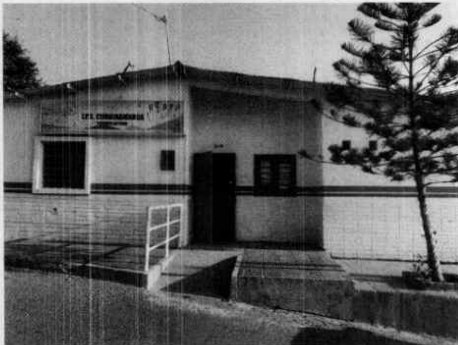
Fotografía de fachada estado actual
