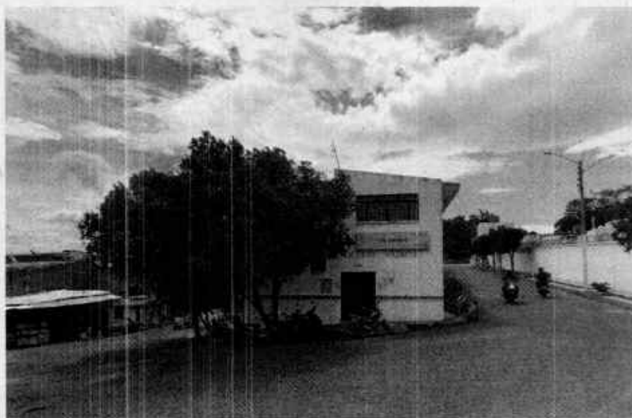
Fotografía de fachada estado actual
