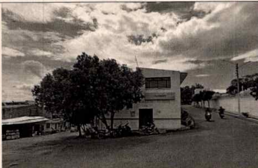
Fotografía de fachada estado actual
