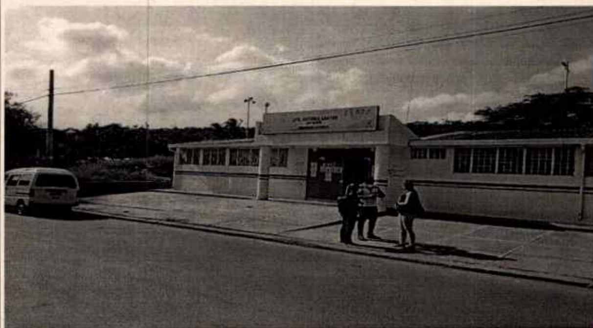
Fotografía de fachada estado actual
