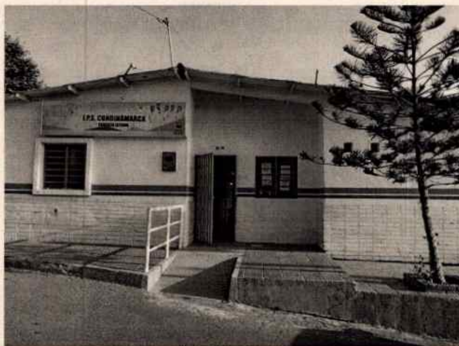
Fotografía de fachada estado actual
