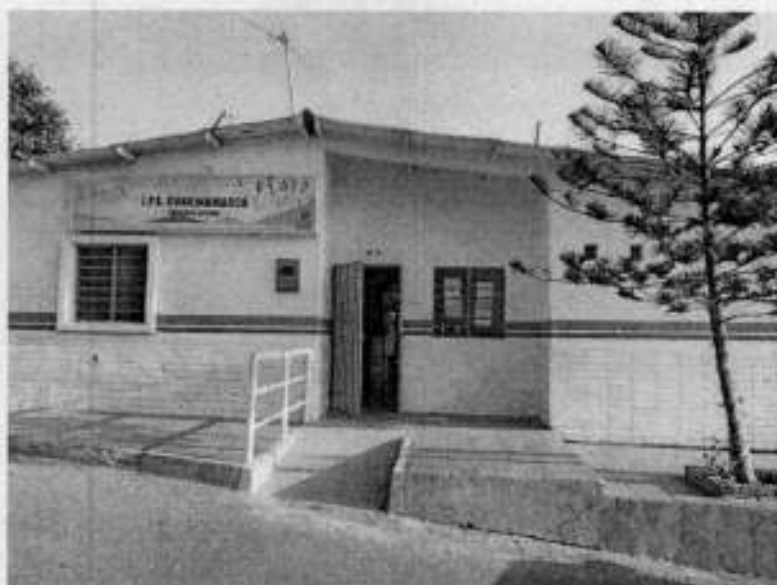
Fotografía de fachada estado actual
