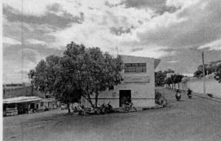
Fotografía de fachada estado actual
