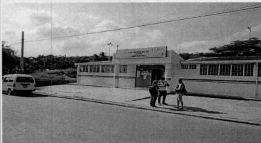
Fotografía de fachada estado actual
