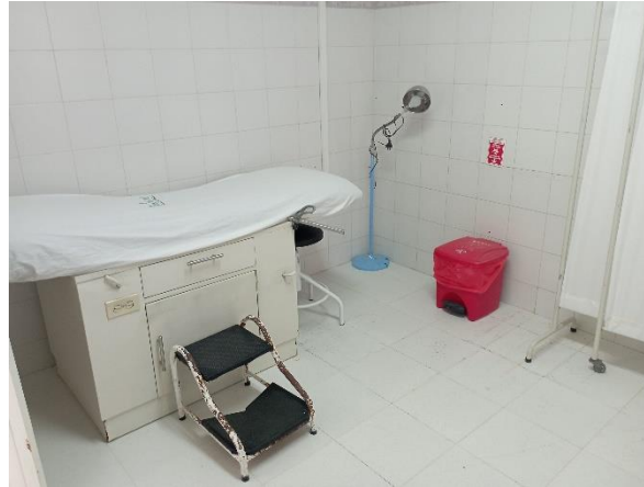
Ilustración 3. Escalerilla deteriorada, IPS BUENA ESPERANZA
