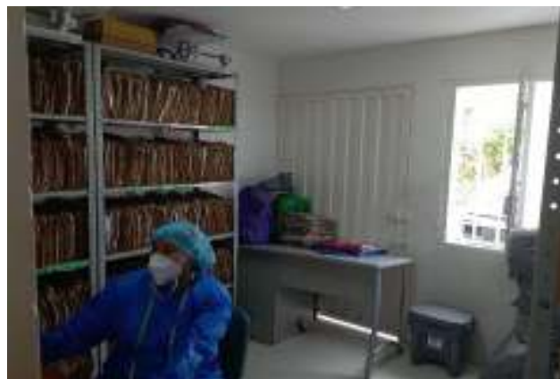
Ilustración 5. Base de escritorio deteriorada, IPS BUENA ESPERANZA
