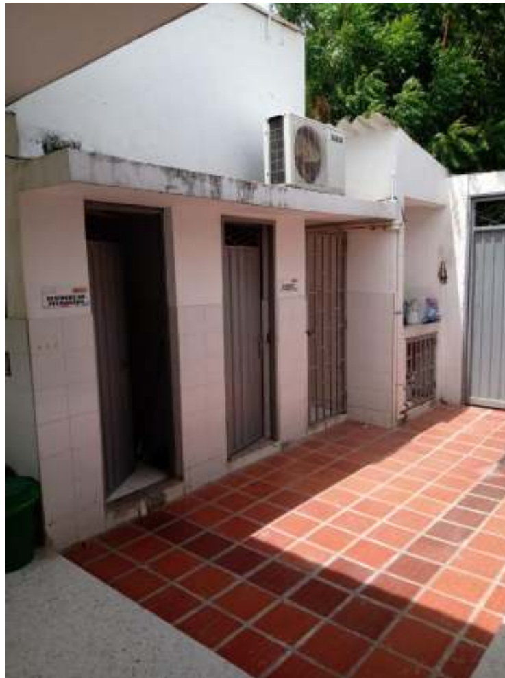
Ilustración 17 – Consultorio área de residuos IPS CUNDINAMARCA
