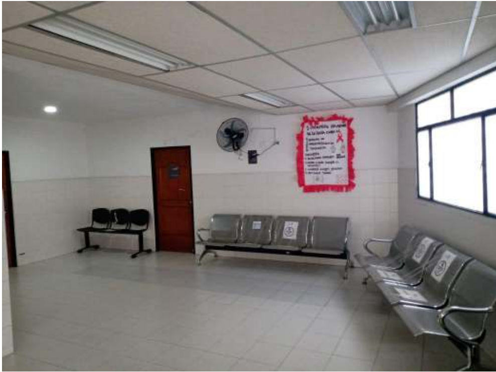
Ilustración 5: Sala de Espera Piso 2 IPS El Contento
