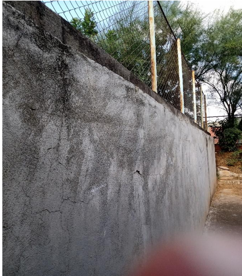
Figura 21. Muro atrás de la IPS – área externa
