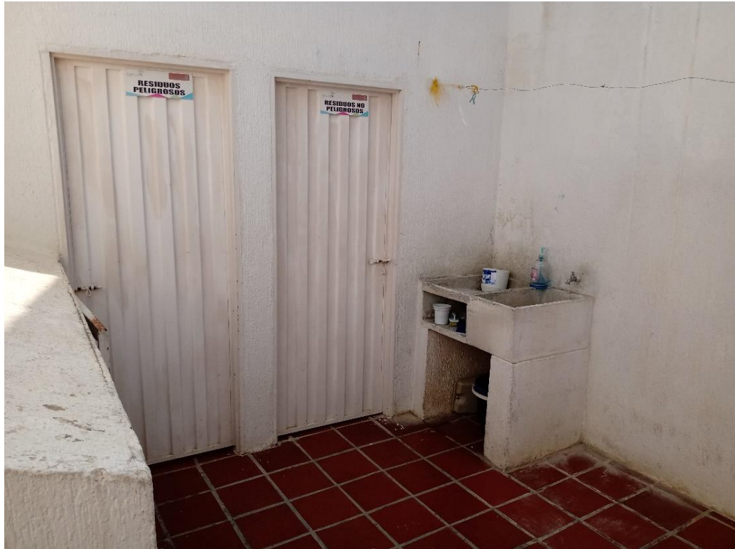
Figura 18. Área de residuos
