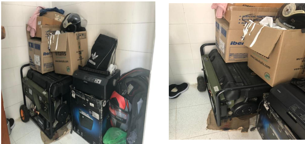
Figure 5 AREA DE EQUIPOS DE BAJA
