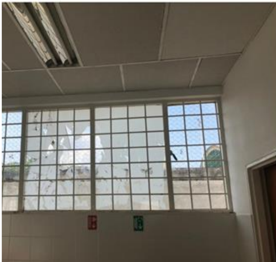
Figura 11. Consultorio medico 1 – ventanas en hierro
