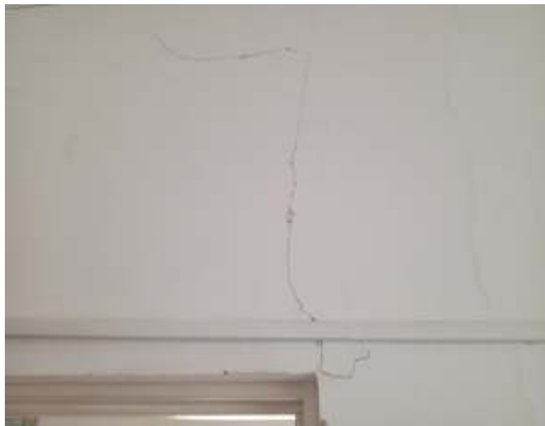
Figura 19. Consultorios pasillos, sala de espera
