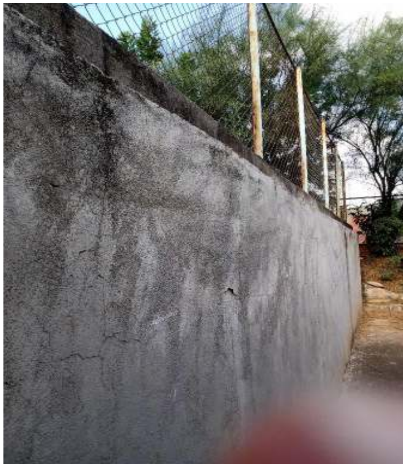
Figura 21. Muro atrás de la IPS – área externa
