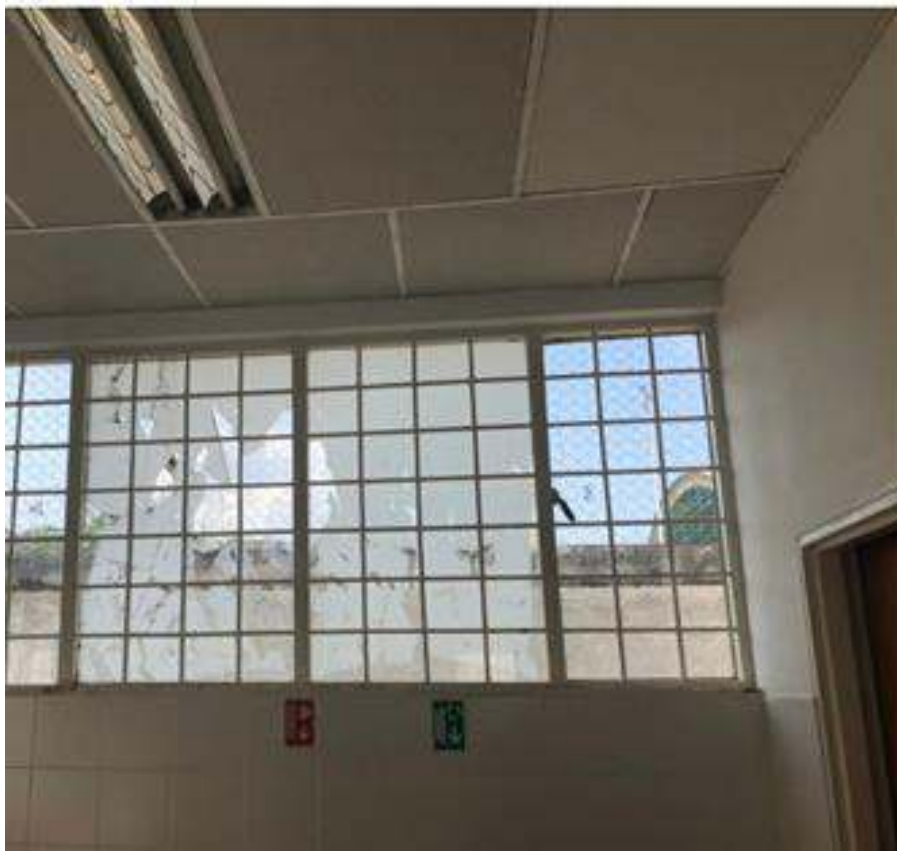
Figura 11. Consultorio medico 1 – ventanas en hierro
